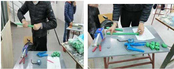
5. Nakon propisanog vremena zagrijavanja ravnomjernim potezom izvući cijev i spojnicu(fazonski element) iz matrica te odmah bez okretanja spojiti.Nakon nekoliko sekundi spoj je ostvaren
