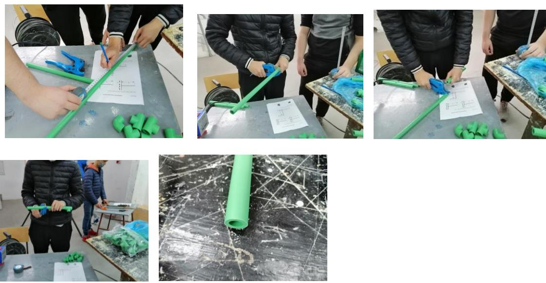
4. Kraj cijevi uvući u prvi dio polifuzorske matrice ravnomjerno i bez okretanja. Istovremeno uvući i spojnicu(fazonski element ) u drugi dio polifuzorske matrice, također ravnomjerno i bez okretanja.
