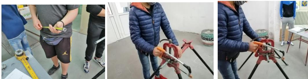
4. Formiranje navoja na krajevima cijevi se vrši pomoću nareznice ,dužina formiranog navoja zavisi od prečnika cijevi.
